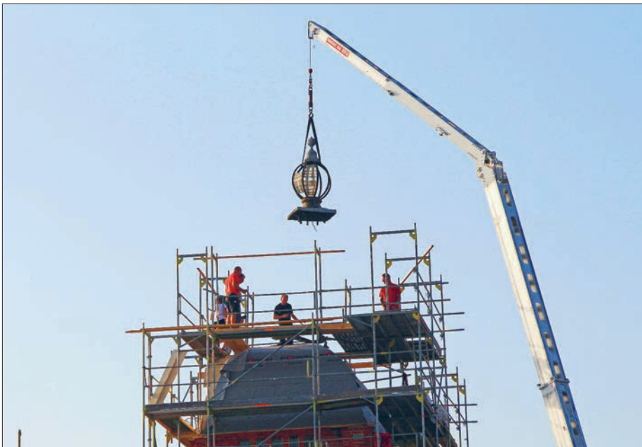
Demontage der Glaskugel auf dem ehemaligen Verwaltungsgebäude der Baumwollspinnerei für die denkmalgerechte Aufarbeitung. Foto: rs.
